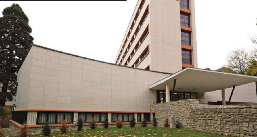
Paris, Maison du Mexique, Atela Architects, ...
